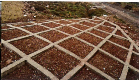
横江大桥已实施的排水沟及网格梁
