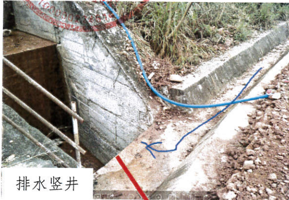
附图1 马延坡弃渣场排水系统图
