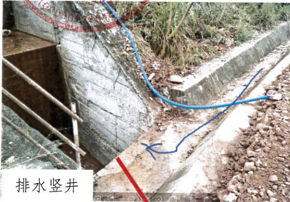
附图1 马延坡弃渣场排水系统图
