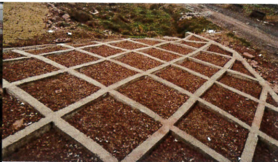
横江大桥已实施的排水沟及网格梁
